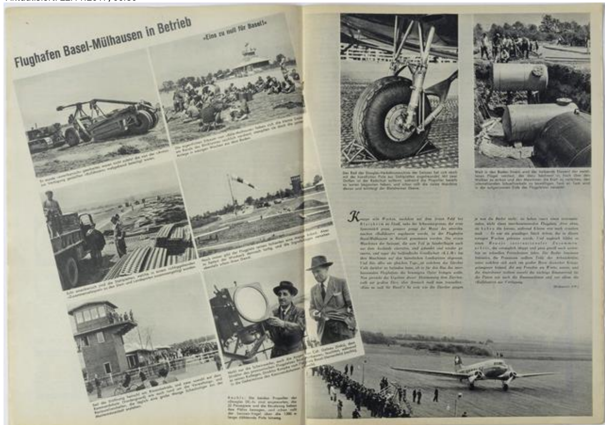
Illustrierte Wochenbeilage «Zeitbilder» vom 11. Mai 1946: Der provisorische Flughafen Basel-Mülhausen wurde in nur zwei Monaten fertiggestellt. Reproduktion: Raisa Durandi
